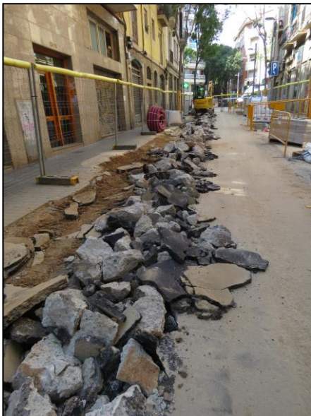
Dues vistes oposades del picatge de l'asfalt i el formigó de la Rasa 8
