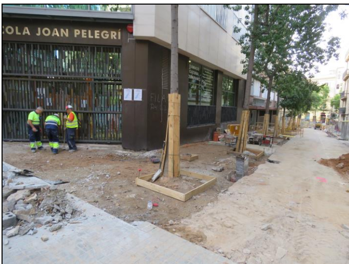
Tres imatges del rebaix realitzat al carrer Torre d'en Damians
