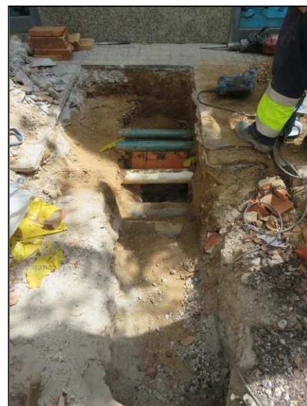
A l'esquerra inici de la Rasa 3 i a la dreta sondeig per localitzar els serveis
