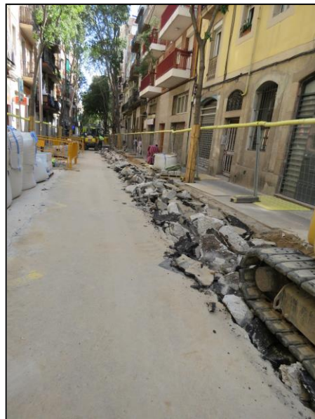
Dues vistes oposades del picatge de l'asfalt i el formigó de la Rasa 8
