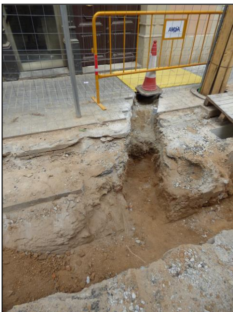
Vista de l'Escomesa 3 durant la excavació i a la dreta un cop realitzada
